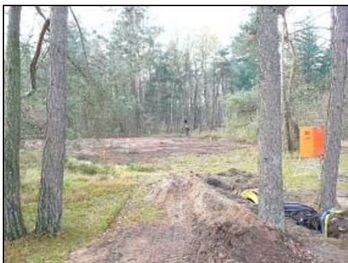
Rond het terrein groeien beide, wilg en pirus. Het terrein is bouwrijp gemaakt door medewerkers van Mennorode
